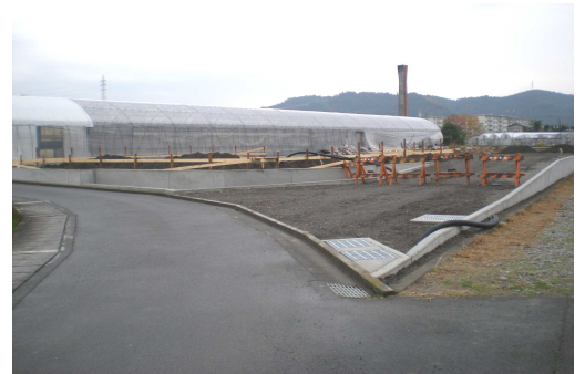
3月の完成に向けて工事が進んでいます。
