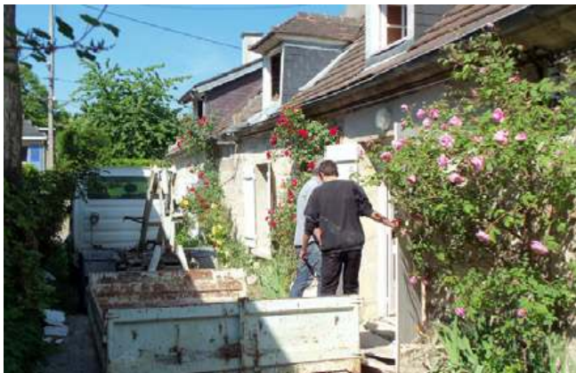
ラモーの家の修理風景
