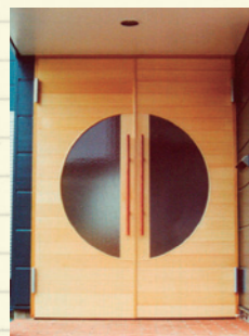
■万吉の家 丸いガラスの木製玄関扉
